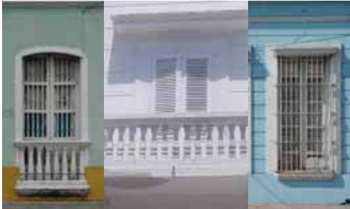
Ventanas con postigo y barrotes de protección, con persianería francesa y entablada con paneles de cristales enmarcados
