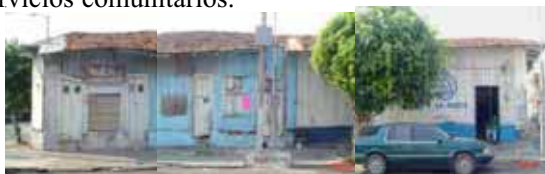
Estado actual de la fachada
