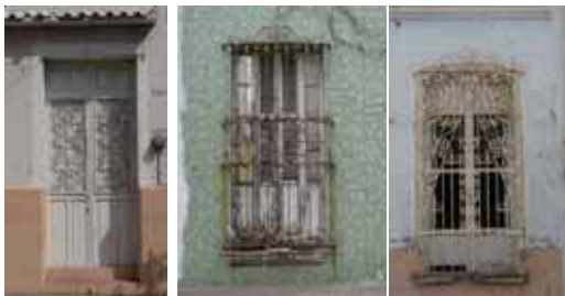
Protecciones en barrotes de madera, en herrería y protección de herrería en ventana con alfeizar.
