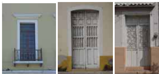
Puertas de doble batiente con cristales enmarcados en madera, de tableros con postigo y barrotes de madera, y de tablero con postigo y herrería.
