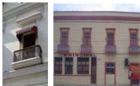
Vanos con sobrejamba, en planta alta
