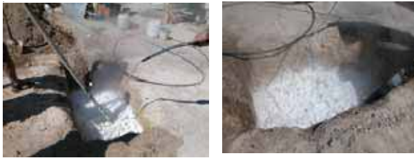
Apagado de cal en un hoyo 54
