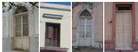
Puerta/ventana y puerta con persianería francesa, puerta con remate superior de lucetas de cristal (de color o claro) y puerta con tableros.
