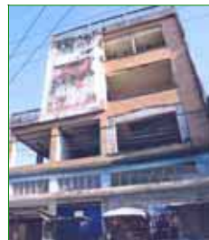
Edificio abandonado en la Calle de Francisco Canal, entre Hidalgo y Bravo. En la planta baja, frente al inmueble, se observa el comercio informal que se extiende a todo lo largo de la cuadra.
