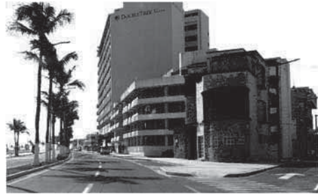
Figura 37. Edificio deteriorado y sin mantenimiento
